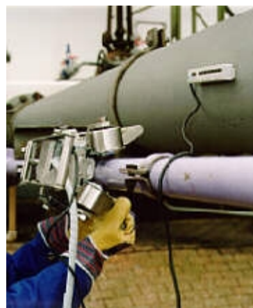
Obr. 18 - Nastavení skeneru na potrubí
