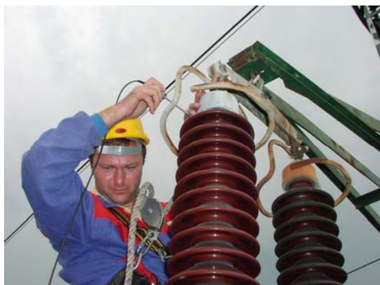
Obr.3 – Meranie ultrazvukom na vedení z vysokozdvížnej plošiny a z lanových závesov
