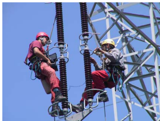
Obr.3 – Meranie ultrazvukom na vedení z vysokozdvížnej plošiny a z lanových závesov
